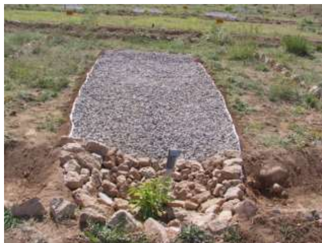
شکل (۴) نمایش از تیمار سامانه آبگیر عایق پس از احداث و کاشت نهال بادام
