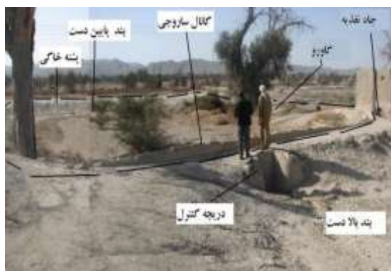
شکل (۴): اجزای سیستم چاه نزو
