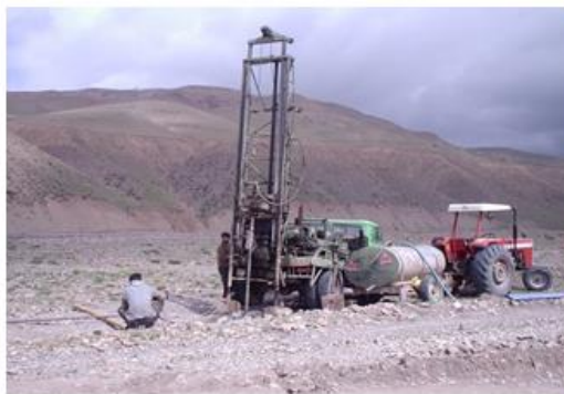
شکل (۷): حفاری چاه‌های ژئوتکنیکی در محور سد
