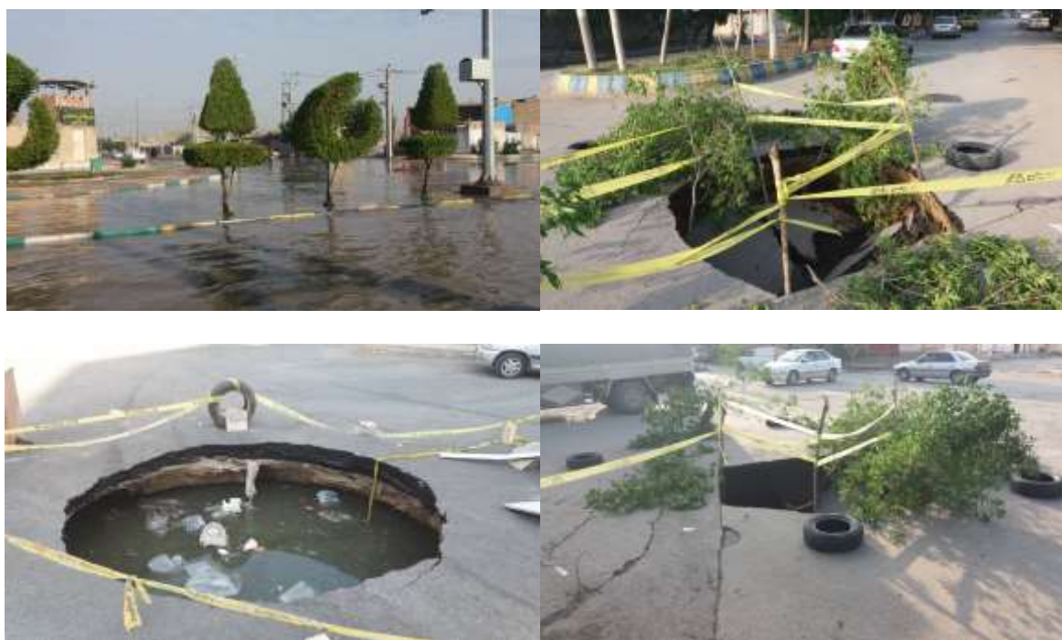
شکل (۱): نمونه‌ای از ریزش خطوط و آب‌گرفتگی معابر در اهواز
