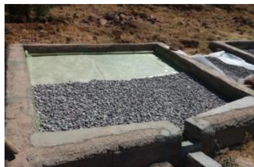
شکل (۴): نحوه اجرا و تکمیل شده سطح آبگیر پوشش نایلون با محافظ شنی
