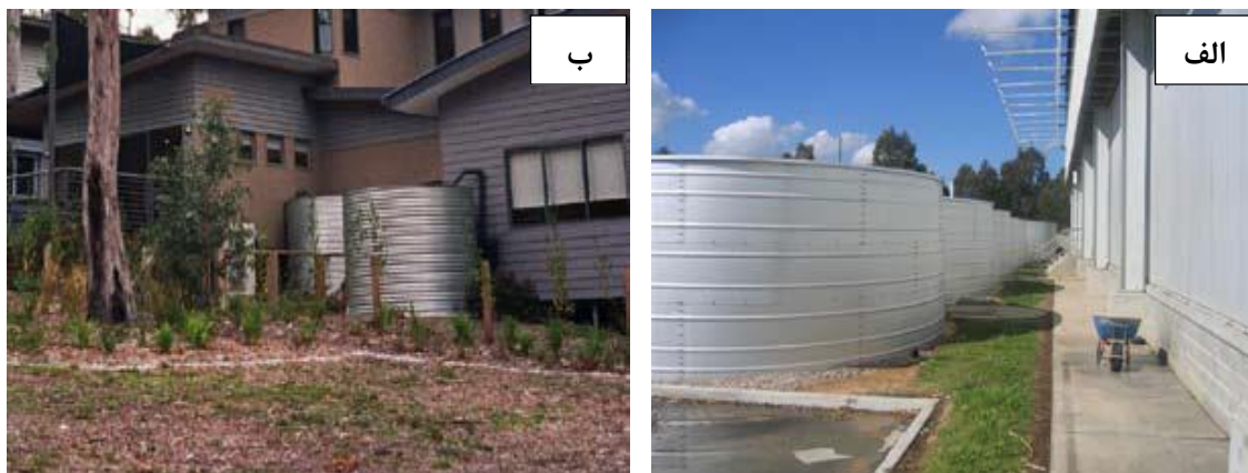
شکل (۷): استحصال آب از سطح پشت‌بام و ذخیره‌سازی آن در مناطق تجاری (الف) و مسکونی (ب) استرالیا
