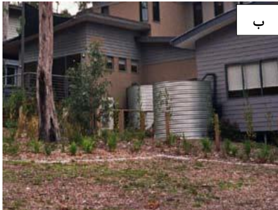
شکل (۷): استحصال آب از سطح پشت‌بام و ذخیره‌سازی آن در مناطق تجاری (الف) و مسکونی (ب) استرالیا
