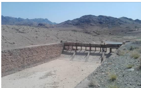
شکل ۶- دهانه آبیگر جانبی با زاویه ۹۰ درجه ساخته شده در رودخانه نای در آبخوان کاشمر Figure 6- A 90-degree lateral Intake Span built on the Nay River on the Kashmar aquifer
