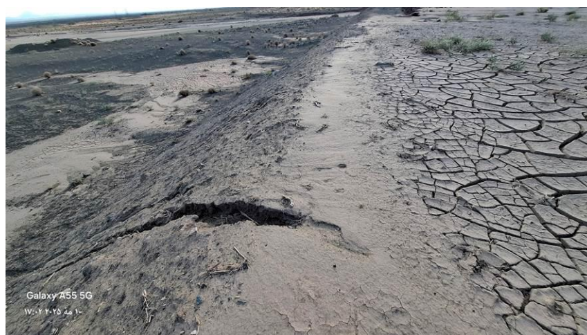
شکل ۹- رسوب‌گذاری زیاد در نهر آبرسان سامانه پخش سیلاب بر آبخوان سبزوار Figure 9- High Sedimentation in the main floodwater transfer channel of the FWSS on the Sabzevar aquifer
