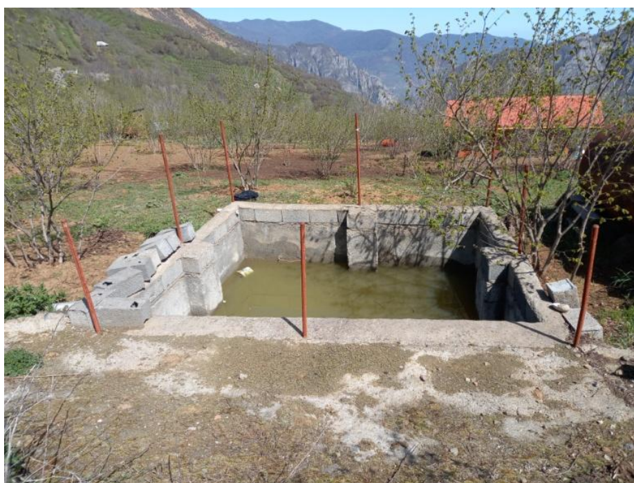
شکل ۲- جمع‌آوری آب باران از سطح کوچک آبگیر و ذخیره آن در مخزن در روستای سراورسو Figure 2- Collecting rainwater from a small catchment area and storing it in a reservoir in the village of Saraversoo
