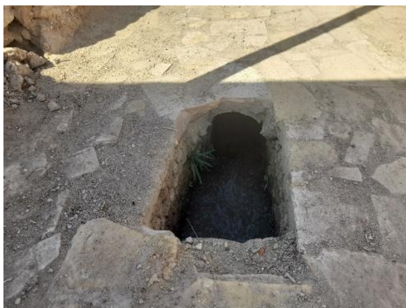
شکل ۹- محل لایروبی قسمت‌های سرپوشیده انهار
