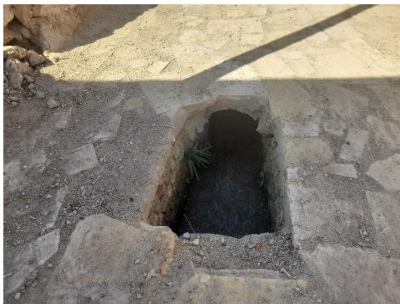
شکل ۹- محل لایروبی قسمت‌های سرپوشیده انهار
