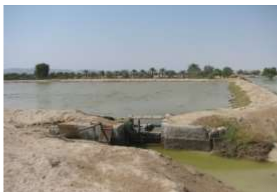
شکل (۵): نمایی از درون چاه نزو با دیواره سنگ و ساروج و دریچه ورود آب به داخل چاه (مدیریت رواناب و تغذیه آبخیز با تزریق مستقیم آب و حذف عبور آب از لایه‌های گچی و املاح نامناسب)
