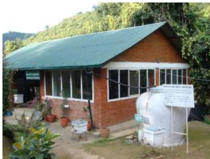
شکل . نمونه سیستم استحصال آب باران با کوزه تایلندی
