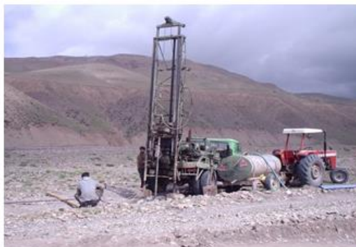
شکل (۷): حفاری چاه‌های ژئوتکنیکی در محور سد
