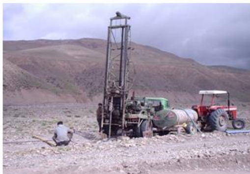
شکل (۷): حفاری چاه‌های ژئوتکنیکی در محور سد
