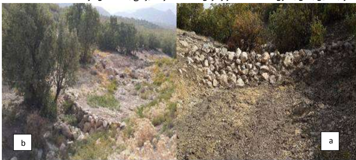
شکل (۲) (a): نمایی از رسوب پشت بند و (b) موقعیت بند در آبراهه در حوضه مرگ
