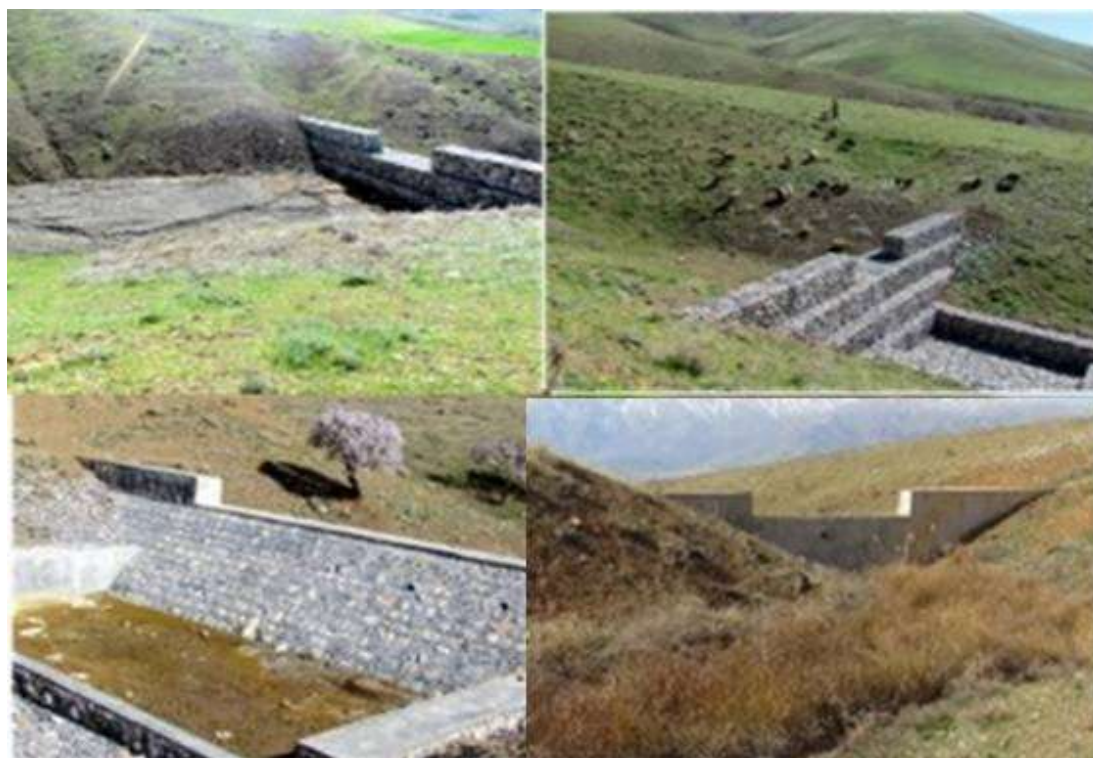
شکل (۴): نمونه بندهای رسوب‌گیر سنگی ملاتی و گایبونی در محدوده آبراهه‌های روستای قشلاق حوضه رزین
