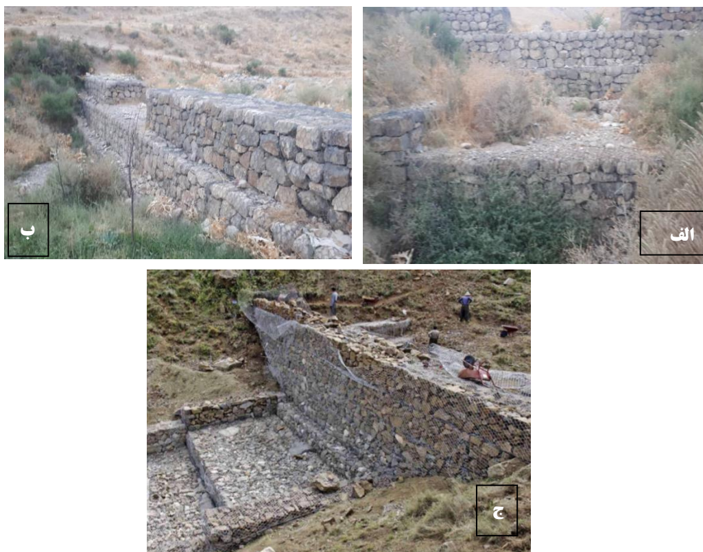
شکل (۲): سازه‌های مکانیکی سرریز پلکانی و حوضچه پایین‌دست احداثی (الف)، تاج سرریز توری‌سنگی و مقطع عرضی آبراهه (ب) و عملیات اجرایی سازه توری‌سنگی (ج)
