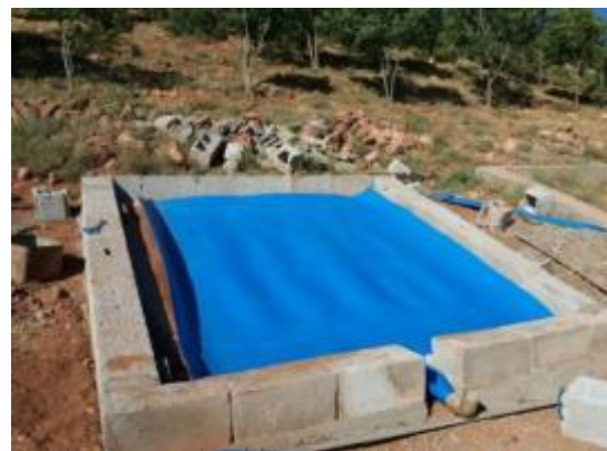
شکل (۳): نحوه اجرا و تکمیل سطح آبگیر پوشش ورق ژئوممبران
