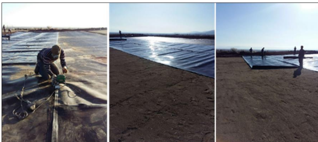
شکل (۲): عایق نمودن سطح سامانه سطوح آگیر باران با استفاده از پوشش ژئوممبران در ایستگاه تسوج
