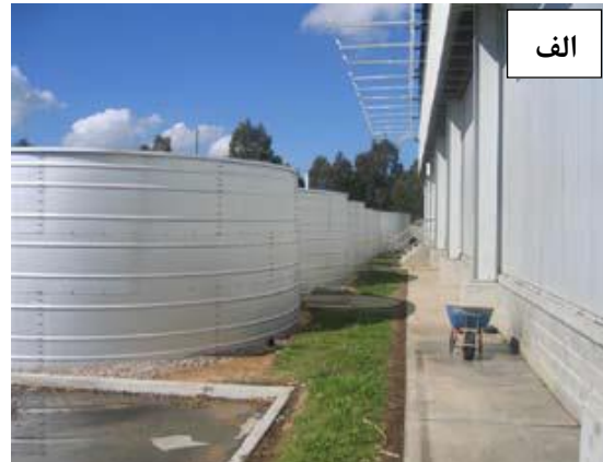
شکل (۷): استحصال آب از سطح پشت‌بام و ذخیره‌سازی آن در مناطق تجاری (الف) و مسکونی (ب) استرالیا
