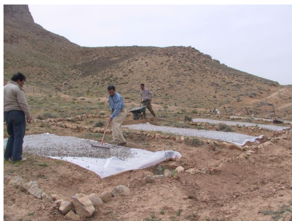
شکل ۵- عایق نمودن سطح سامانه آبگیر با استفاده از پلاستیک و سنگریزه
