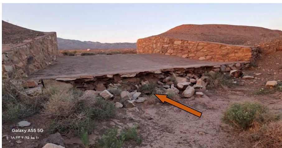
شکل ۱۱- پدیده آب‌شستگی پایین دست دروازه عبور جریان در سامانه پخش سیلاب بر آبخوان سبزوار
