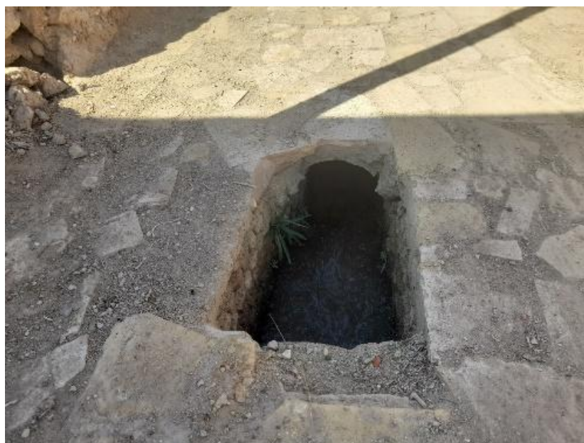
شکل ۹- محل لایروبی قسمت‌های سرپوشیده انهار
