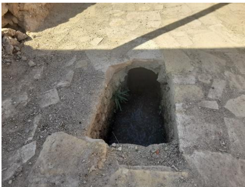
شکل ۹- محل لایروبی قسمت‌های سرپوشیده انهار
